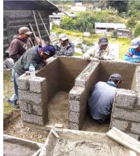
Figura 13. Aplanado de muros interiores
