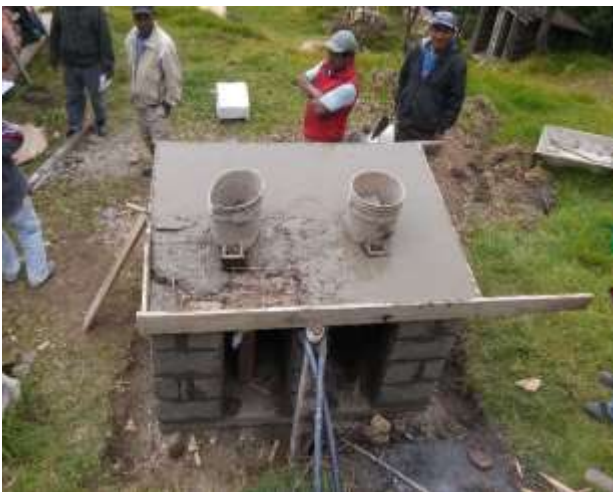
Figura 18. Colado de la losa de concreto
