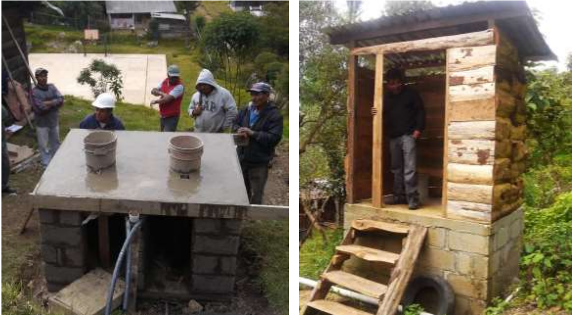
Figura 19. La caseta del baño seco se construye con materiales de región
