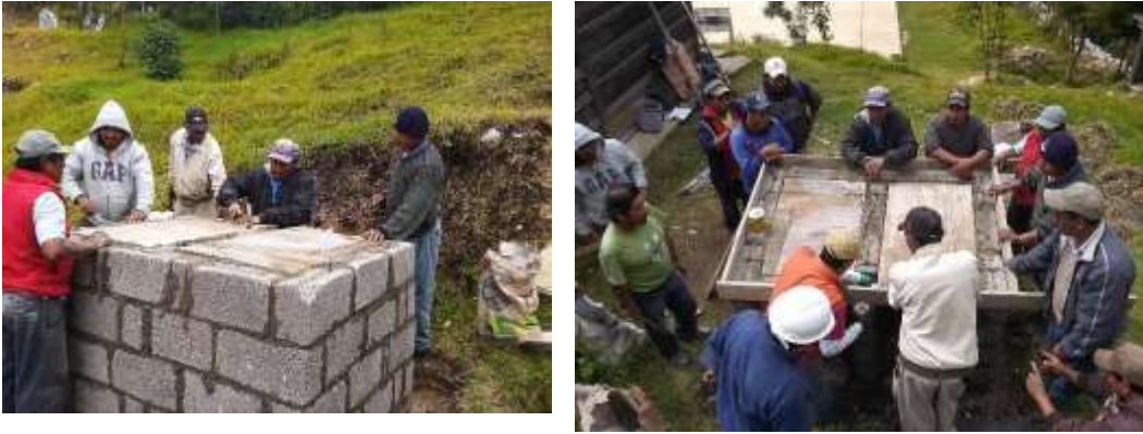
Figura 15. Construcción la cimbra sobre las cámaras e instalación de PVC para gases.
