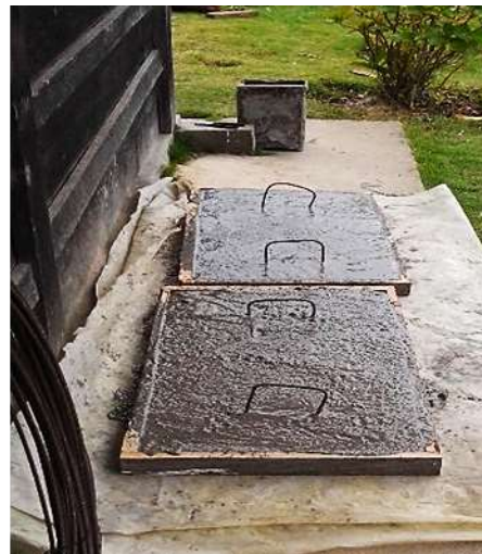
Figura 10. Colocación de las asas de las tapas
