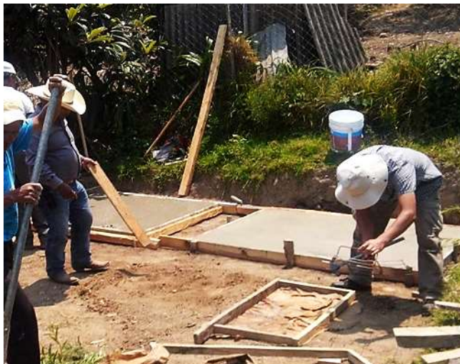
Figura 10. Colocación de las asas de las tapas
