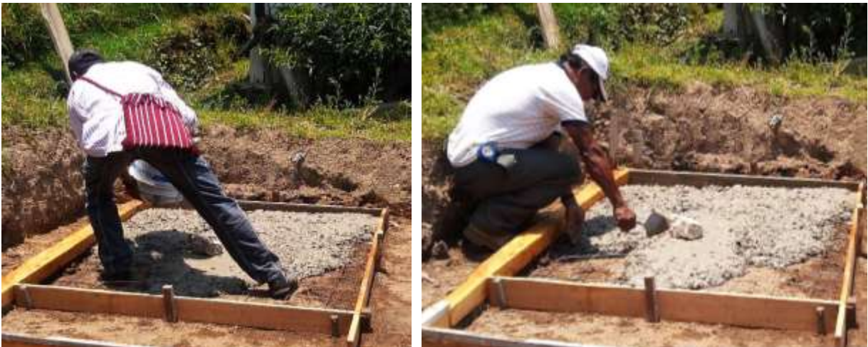
Figura 8. Colado de la losa de cimentación
