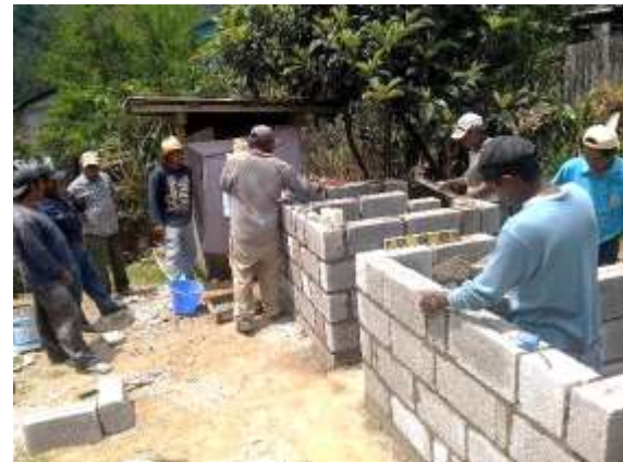
Figura 11. Desplante de muros de las cámaras del baño
