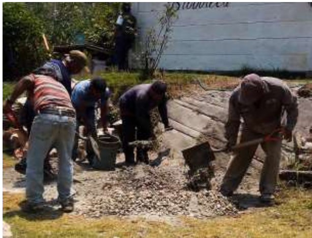
Figura 6. Mezcla para la losa de cimentación del baño
