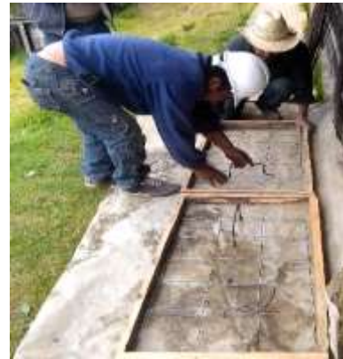
Figura 9. Colado de la losa de cimentación
