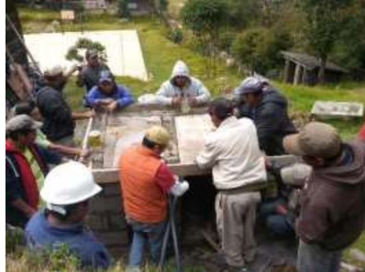
Figura 16. Mangueras de orina y armado de tubería de gases integrados a la losa
