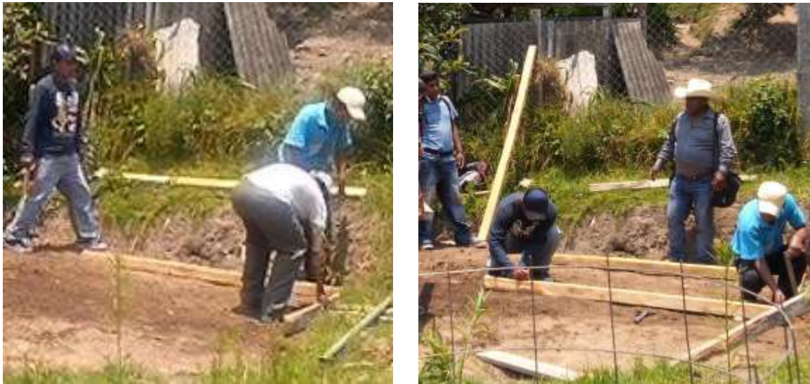
Figura 3. Trazo de la base del baño y la cimbra para construir la losa de cimentación.
