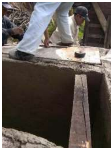
Figura 14. Colocación Cimbra, malla electro soldada y tubería de orina y gases
